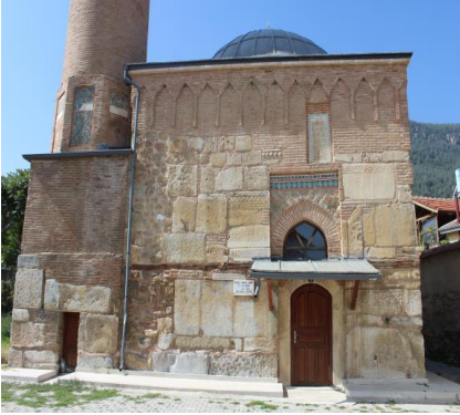
7- Güdük Minare Camii
