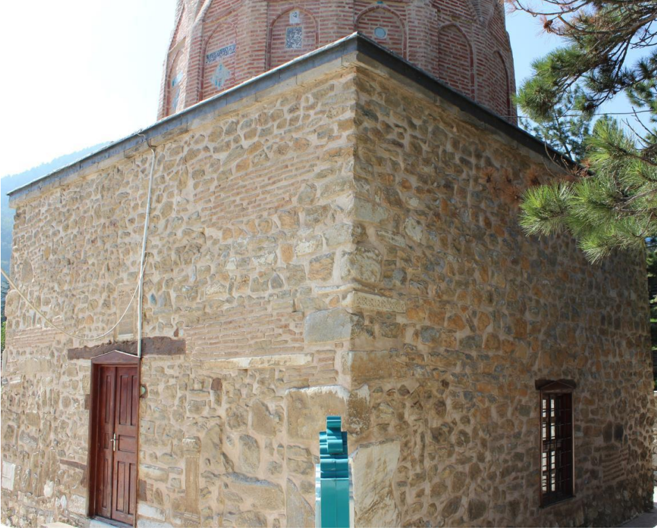
15- Mahmut Hayran Türbesi, Doğu ve Kuzey Duvarları
