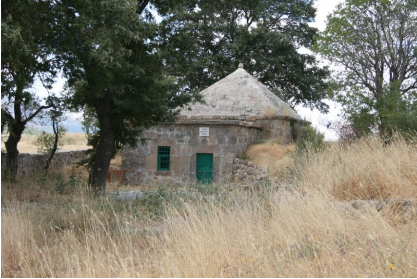
Fot. 4.: Yenipınar Köyü Hacı Gaybi Türbesi
